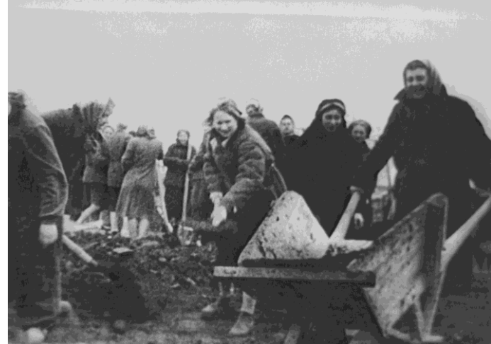
Студентки ИФФ на строительстве ГЭС-2
