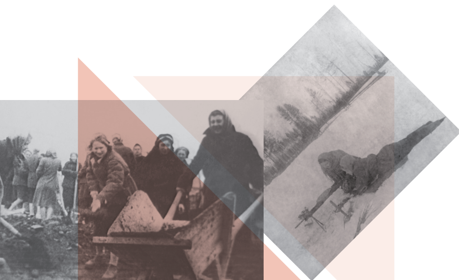
На строительстве ГРЭС II. 1943 г.
